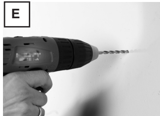
Bohrungen entsprechend den Hinweisen der Dübelhersteller vornehmen. Dübel in Bohrlöcher stecken.
