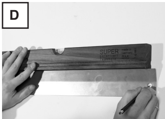
Die demontierte Montageleiste an der Wand ausrichten, Bohrlöcher anzeichnen.
