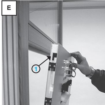
**E** Front in den Falz einstellen und ausrichten. ① Ausschnitt für Kabelzufuhr, wenn Sprech-Klingelfach vorhanden!
