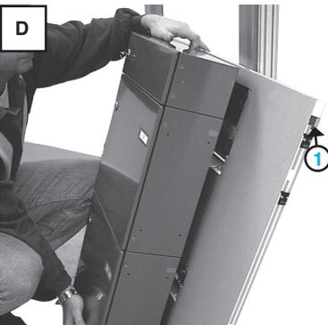
**D** Kastenblock nach oben schieben und aushängen. ① Ausschnitt für Kabelzufuhr, wenn Sprech-Klingelfach vorhanden! Kastenblock entfernen.
