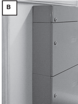
Anlage in Falz stellen und ausrichten.
